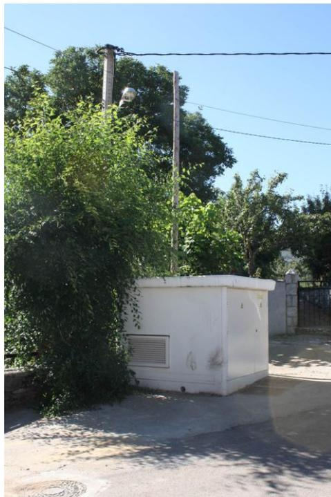
En principio se valora como suficiente la capacidad de suministro para el aumento de población previsto, aunque para proporcionar una energía suplementaria bastaría con la sustitución en la misma parcela por un transformador de mayor capacidad, sin alterar más que las secciones de algunos de los trazados urbanos o aumentar el número de cables.
